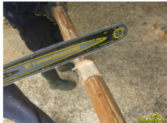
T opore smo v našem primeru izdelali iz smrekovih sušic. **Smrekove sušice** smo predhodno olupili, dodatno posušili na soncu in odrezali na dolžino 3,7 metra. V spodnjem delu smo nosilne stebre z motorno žago ošilili v špico. Prečne letve smo pritrdili 10 cm od vrha nosilnega stebra.
