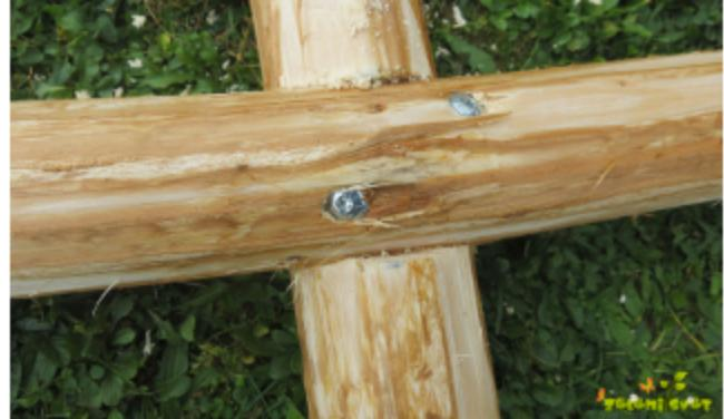
Za dober spoj smo v prečno letev in v nosilni steber zažagali utor. Tako sta se prečna letev in nosilni steber trdno spojila. Dodatno smo jih povezali z 20 cm vijaki za tramove.
